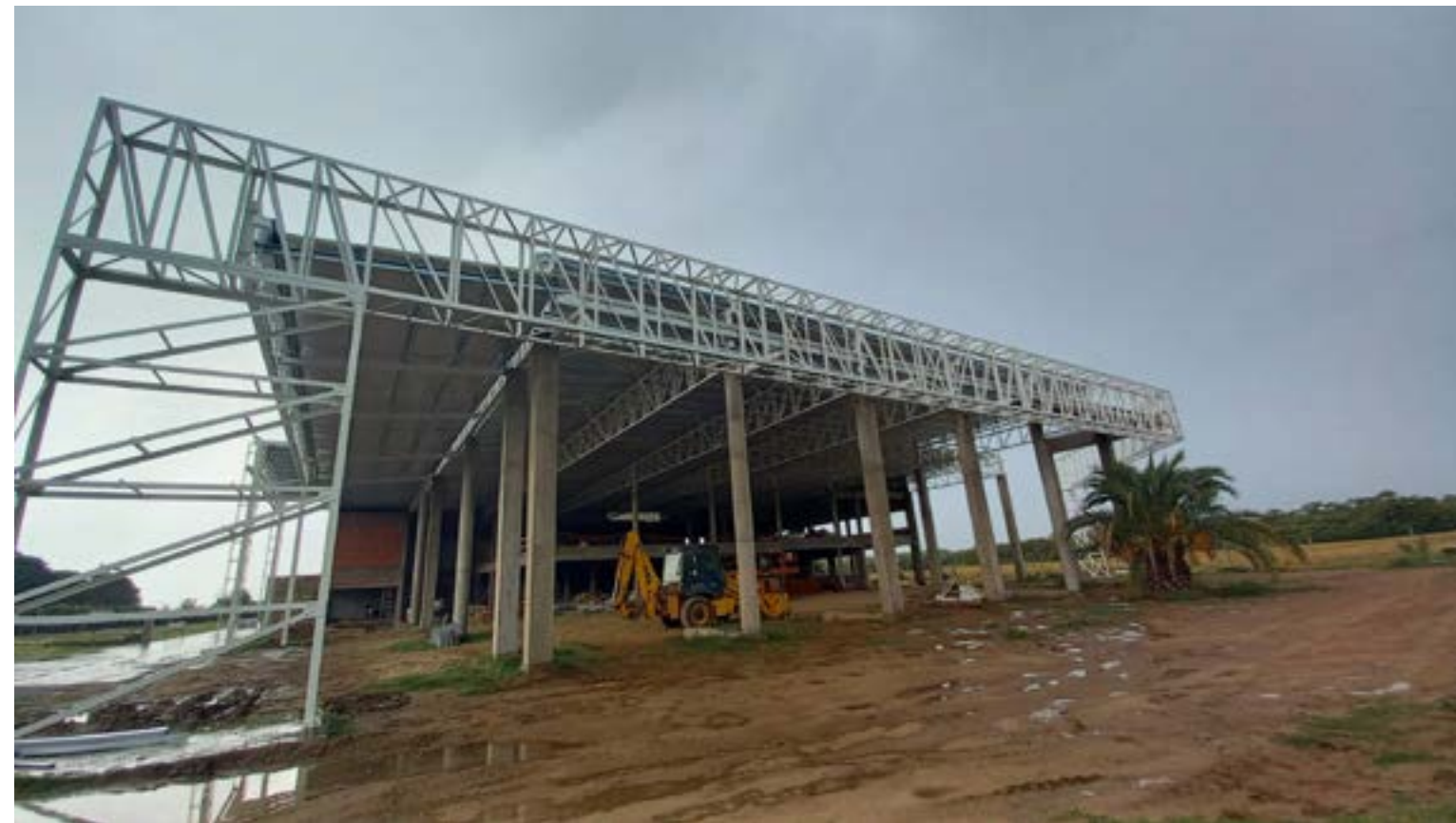
Proceso de edificación.
